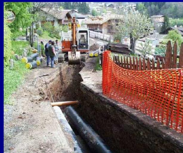
Esempio di posa in opera delle tubazioni per il teleriscaldamento.
